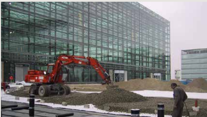
Pose et répartition du matériau au moyen d'une pelleuse
