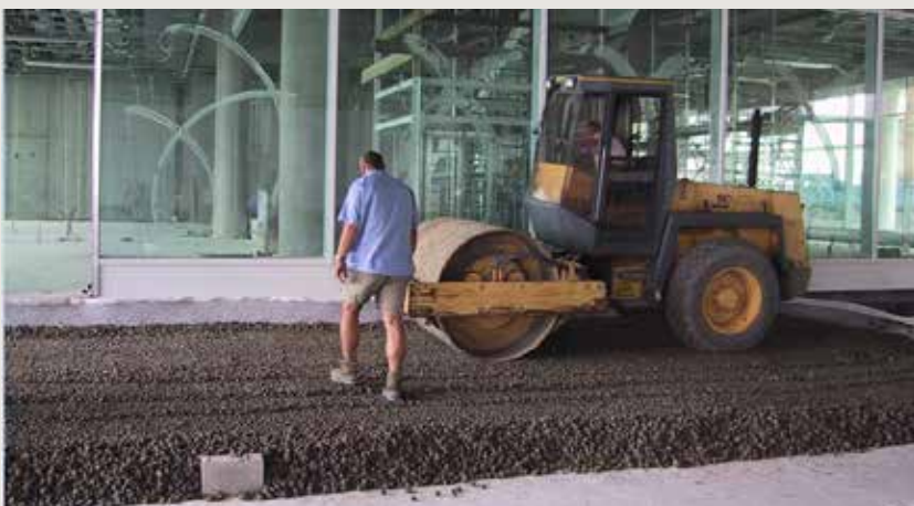
Compactage au rouleau ou à la plaque vibrante
