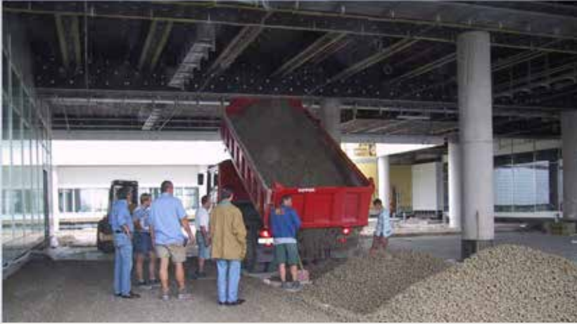
Transport depuis la centrale jusqu'au chantier
