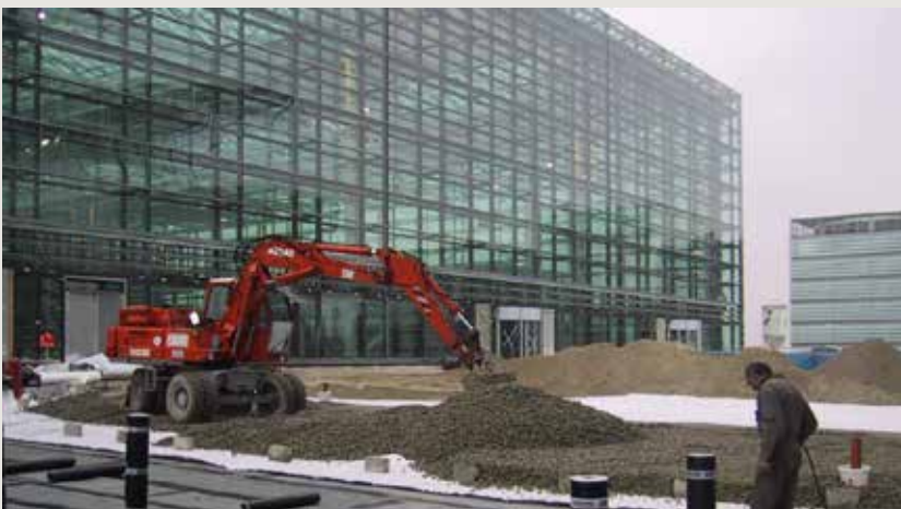
Materialeinbau und Verteilung mit Bagger
