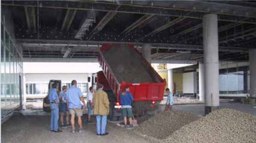
Transport vom Mischwerk zur Baustelle
