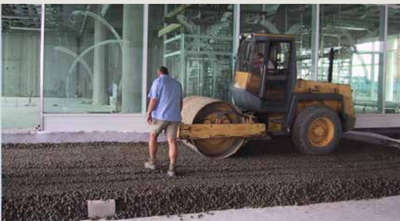
Verdichtung mit Walze oder Rüttelplatte
